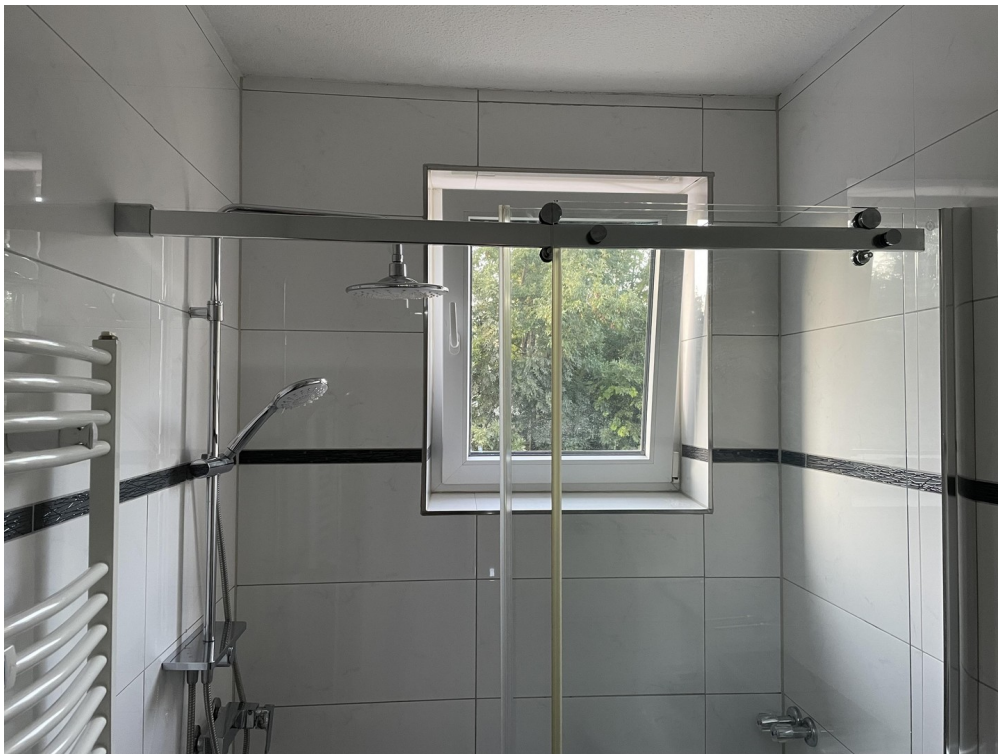
Badezimmer inkl. Fenster
