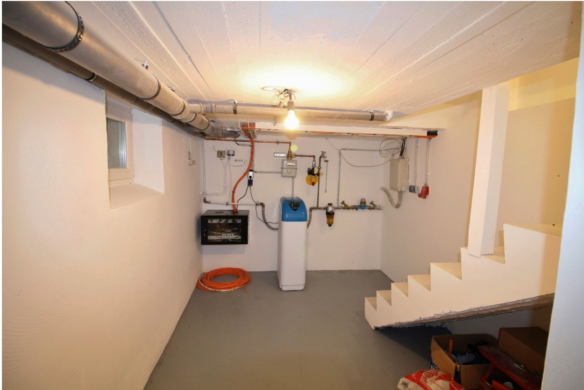
Teilkeller mit Hausanschlüssen
