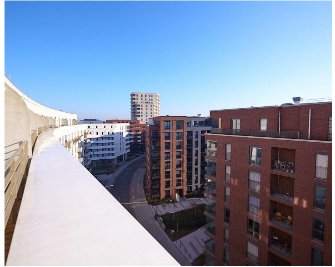
BLICK VON DER WESTLOGGIA
