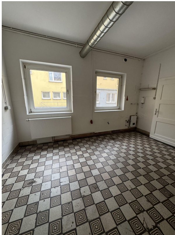
Küche Blick Richtung Hof
