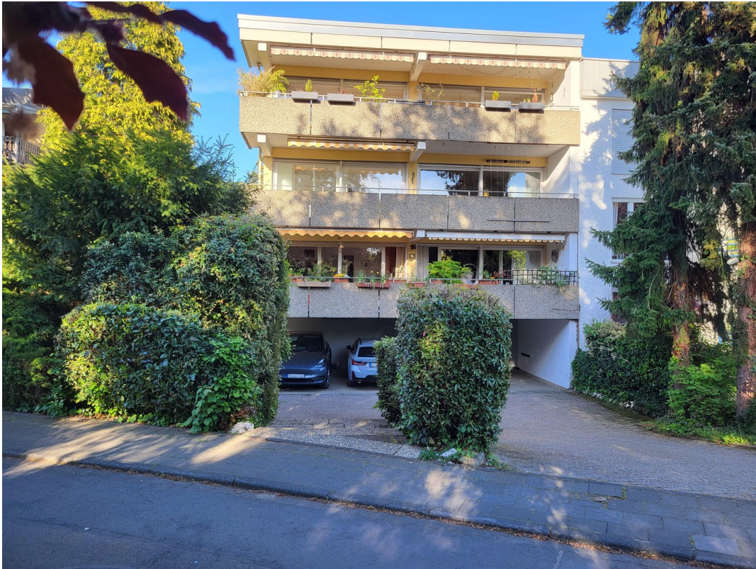
Ansicht der Straßenseite
