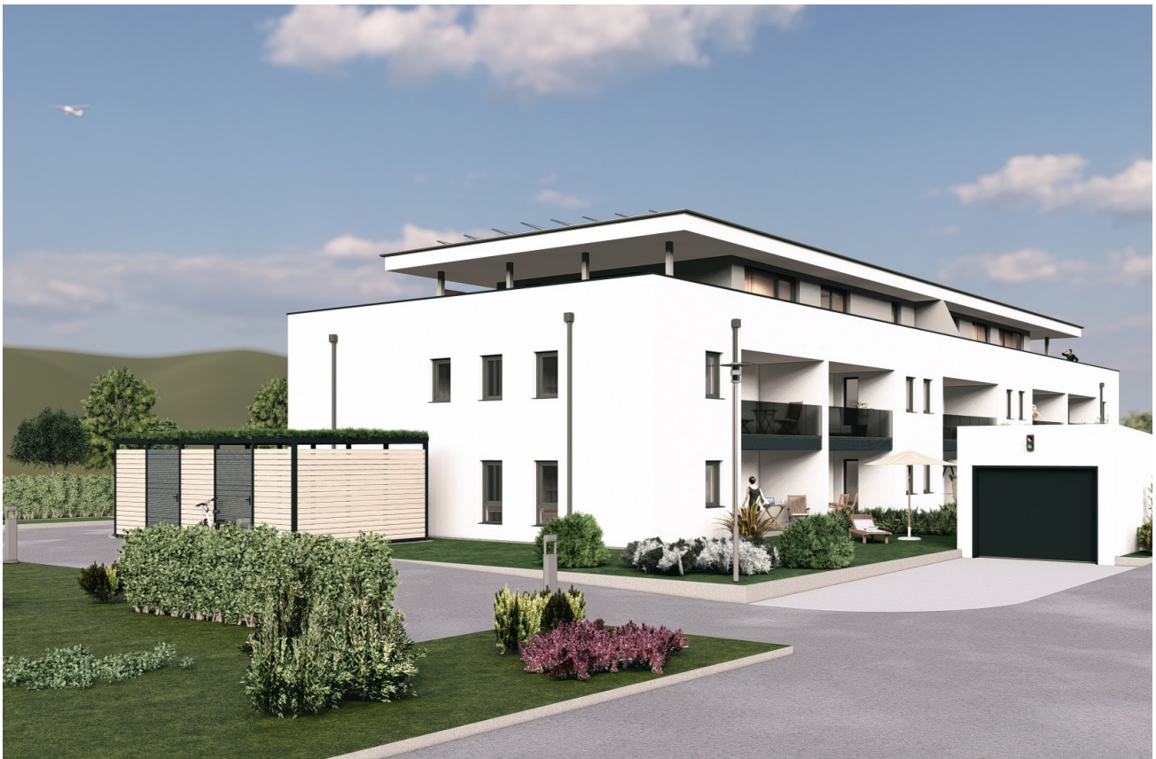
Ansicht von Süd-West
