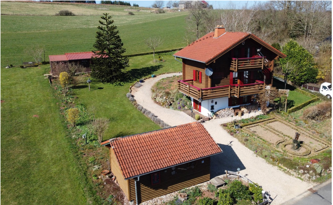
Carport, Haus und Gartenhaus
