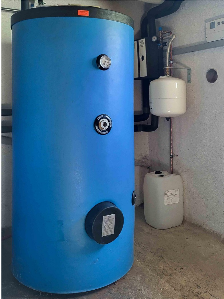
Pufferspeicher Solaranlage
