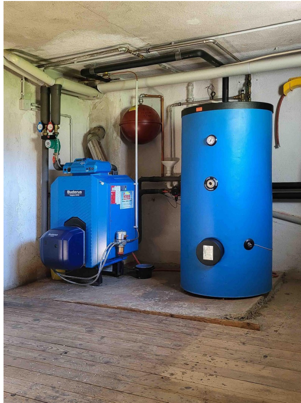
Heizungsanlage/Pufferspeicher
