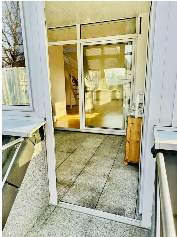
Eingang über Kaltwintergarten
