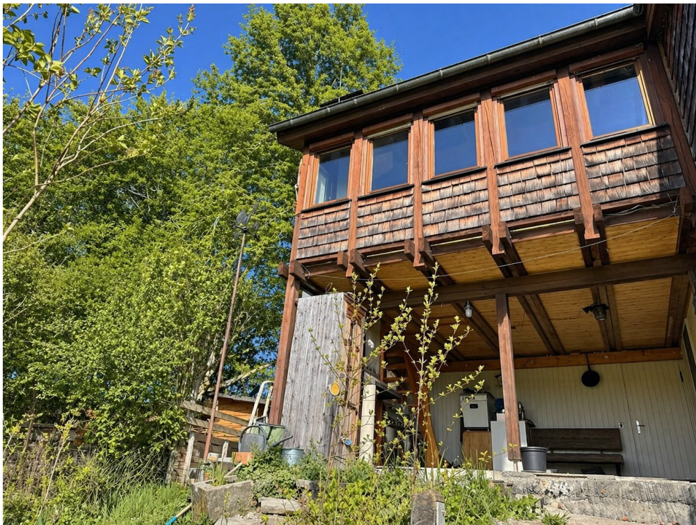
überd. Terrasse Gartenansicht
