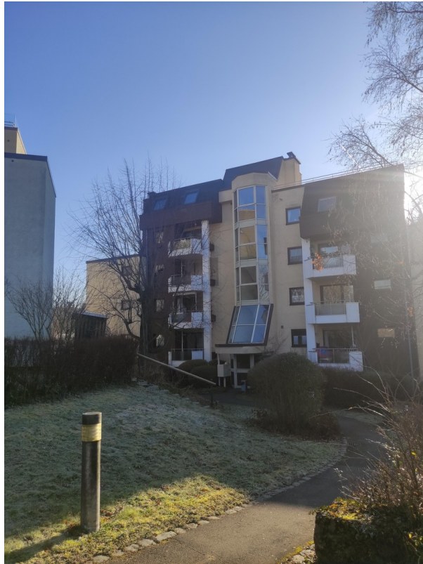
Haus Außenansicht von Norden
