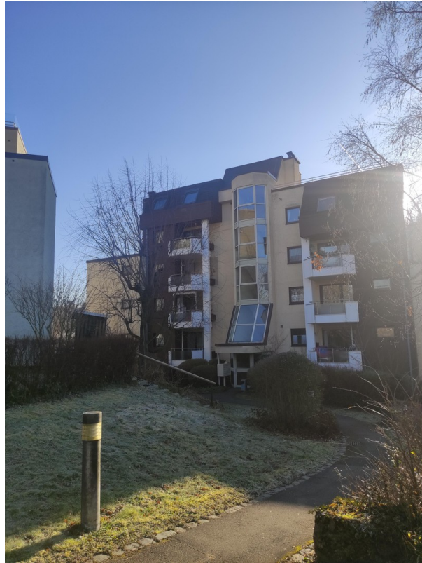
Haus Außenansicht von Norden
