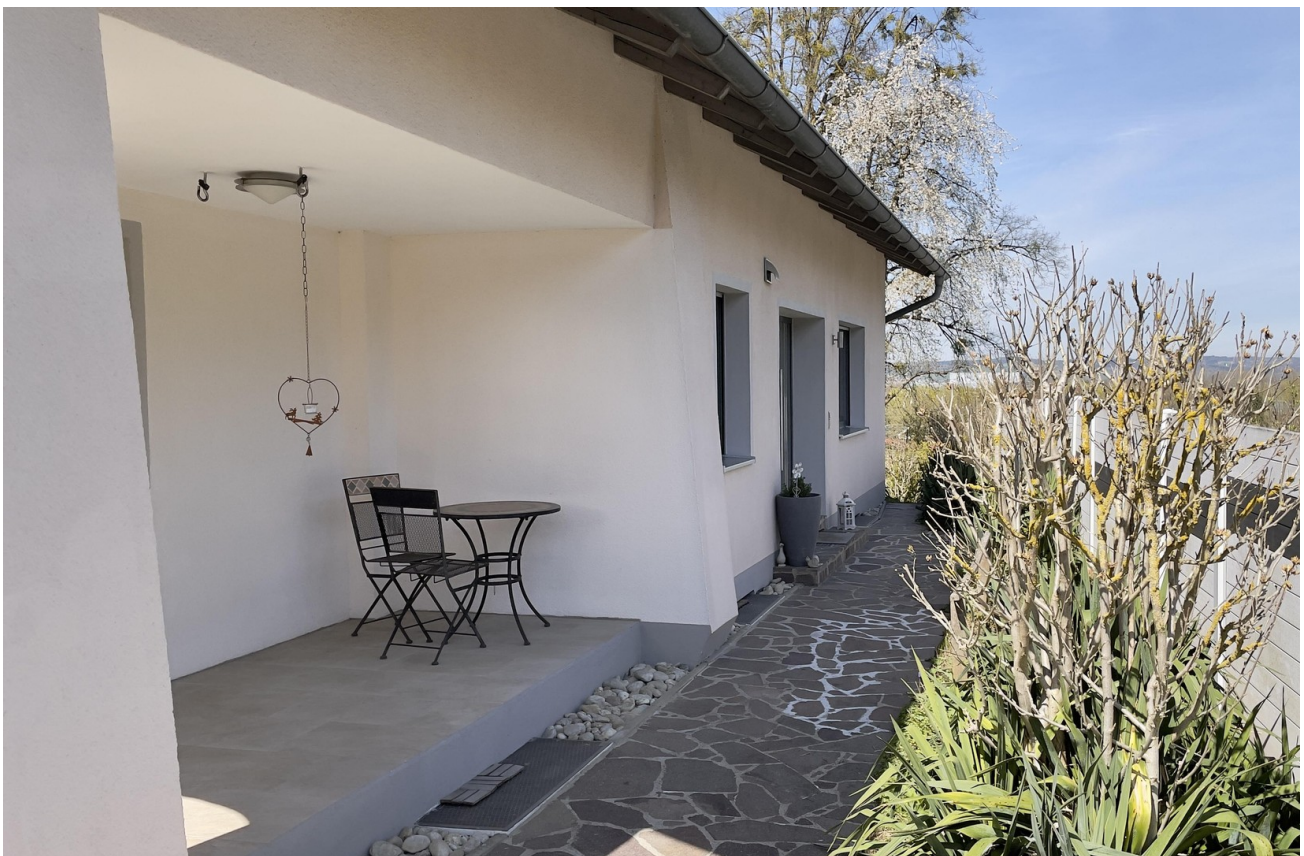
Ostseite mit Haustür
