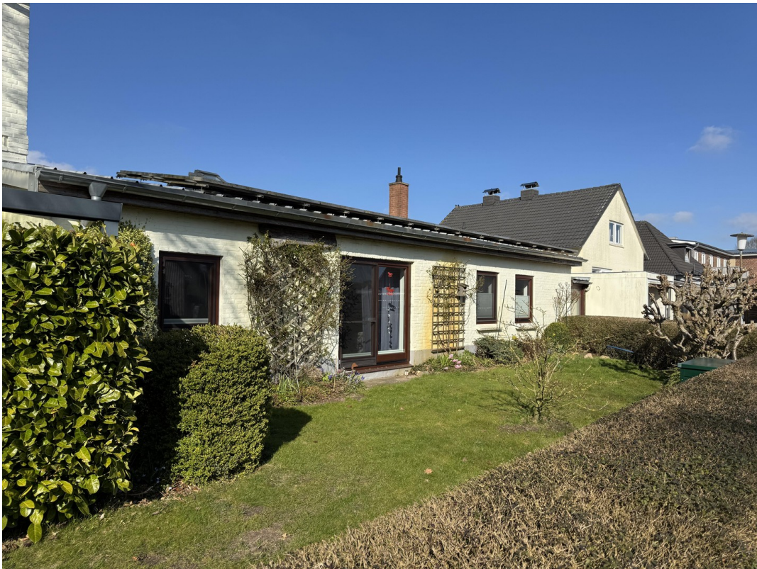
Eingeschossiger Teil Süd
