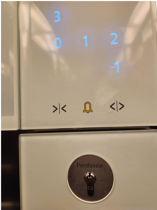
Schlüsselschalter im Aufzug
