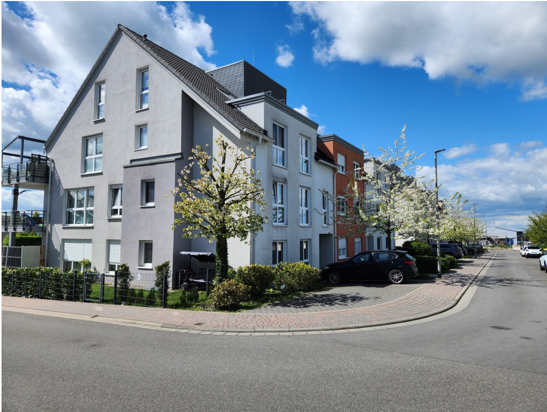
Übergroßer Stellplatz (Südost)
