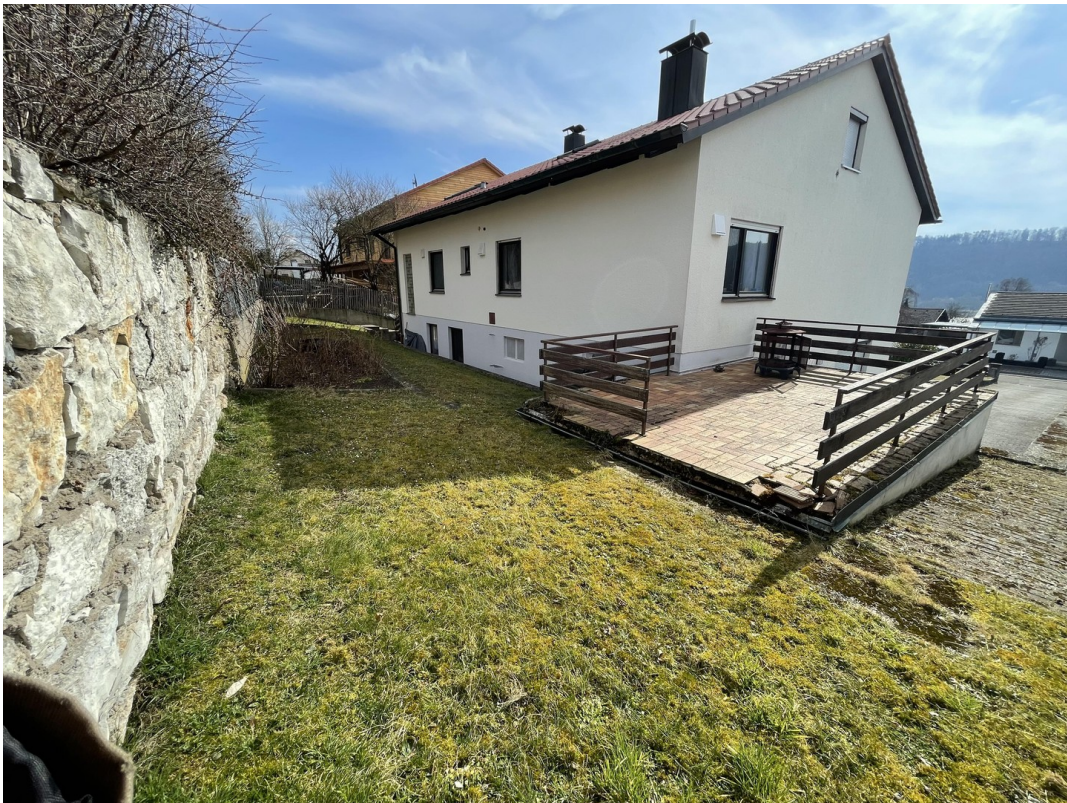
Westseite mit zusätzl. Terrasse
