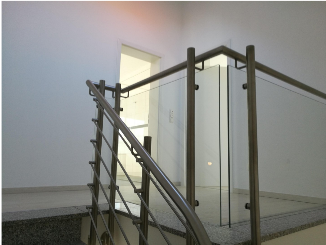
Treppe/Flur zum DG
