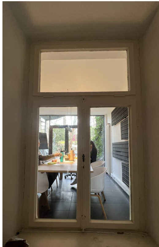
Untergeschoss Blick in Raum
