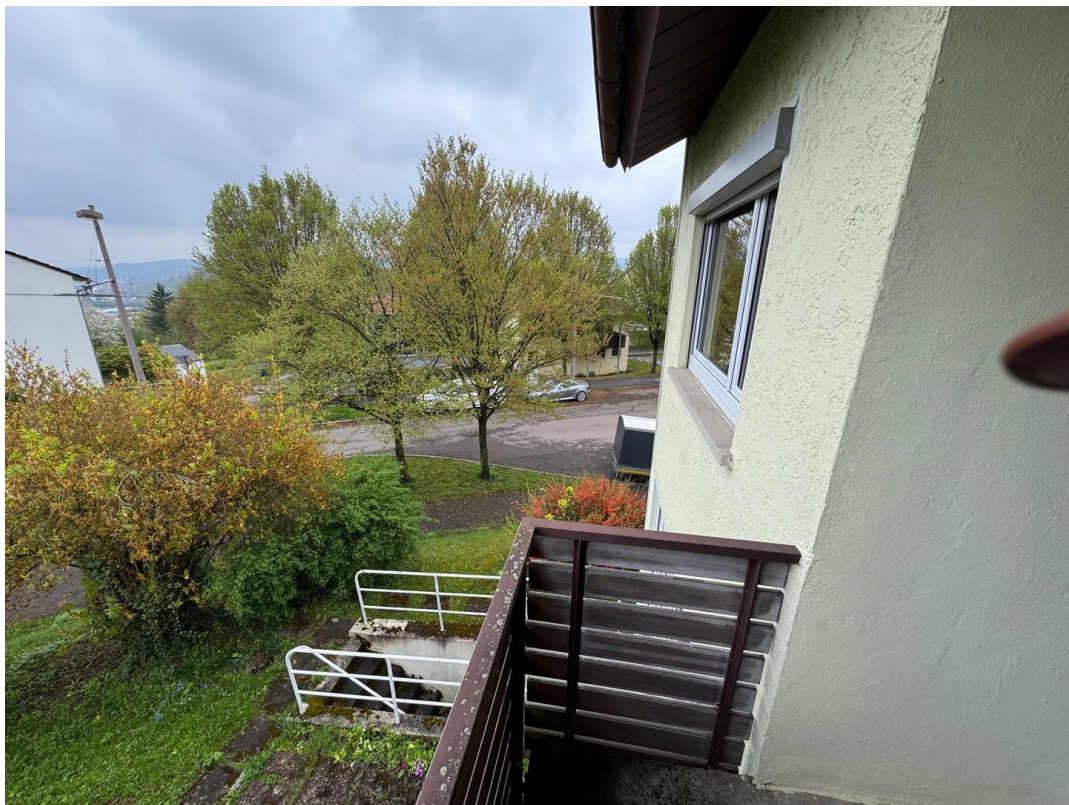
Zimmer 2, 1. OG Blick Balkon
