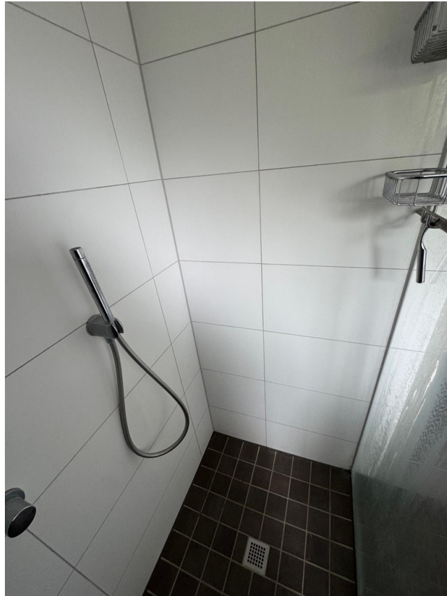
Bad 1. OG Dusche
