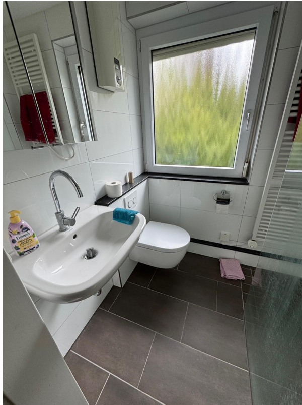
Bad 1. OG WC
