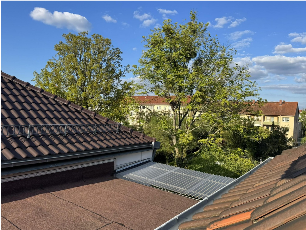
Dachterrasse nach Osten
