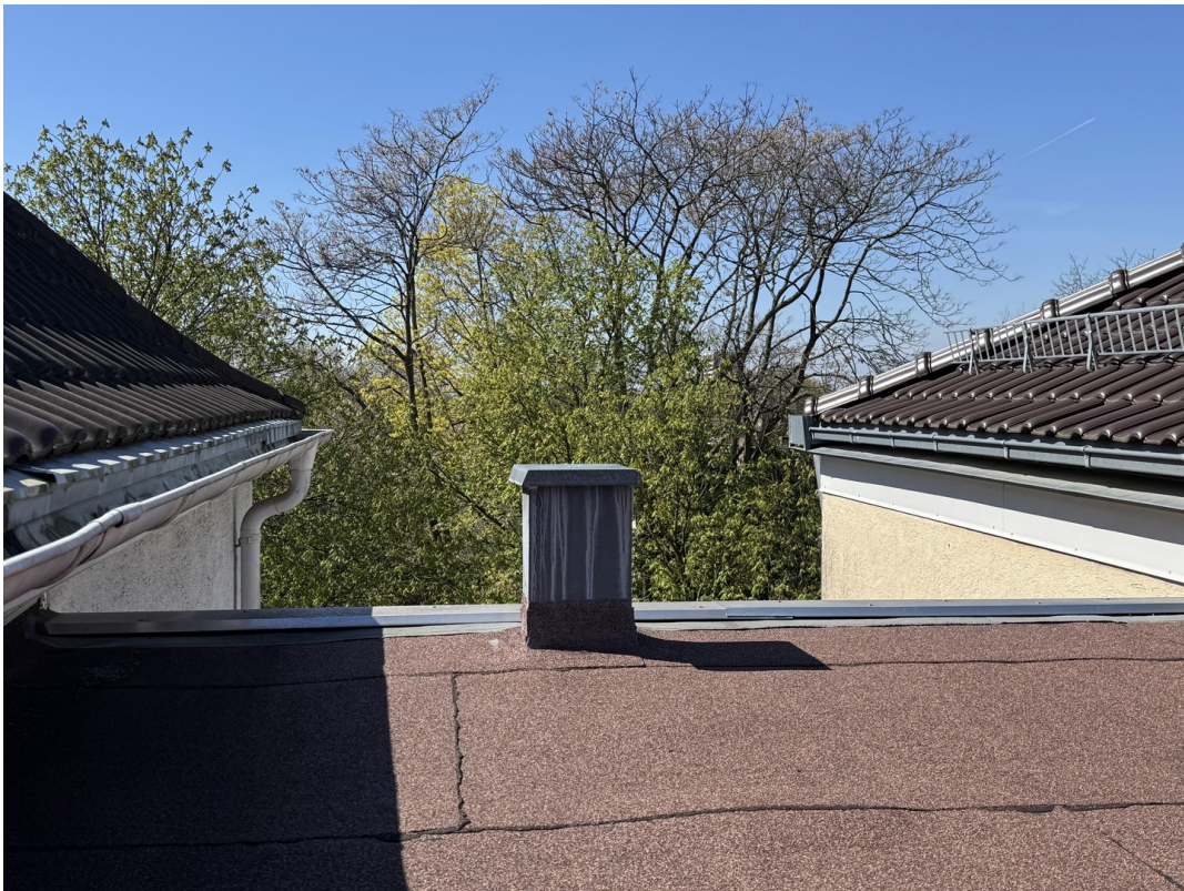
Blick Dachterrasse nach Westen
