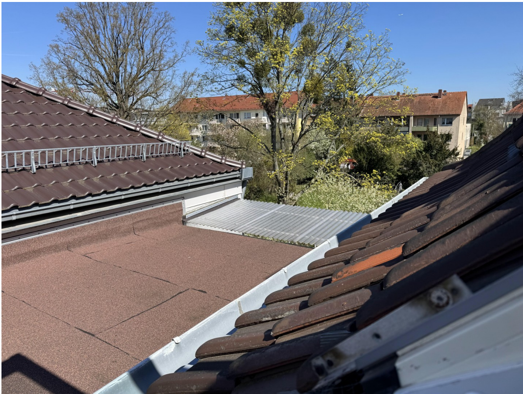
Östlicher Teil DachterrasseBli
