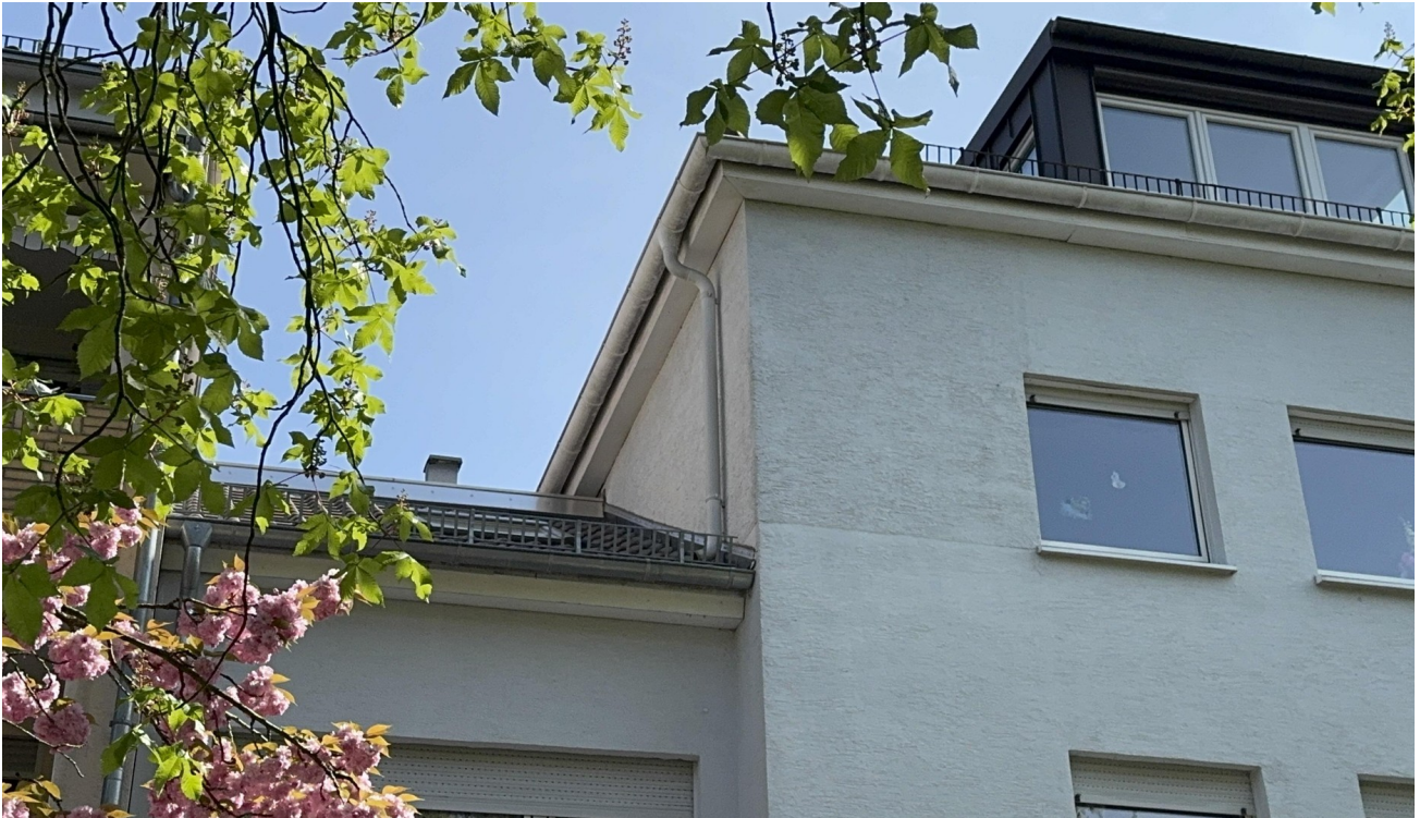
Dachterrasse von unten
