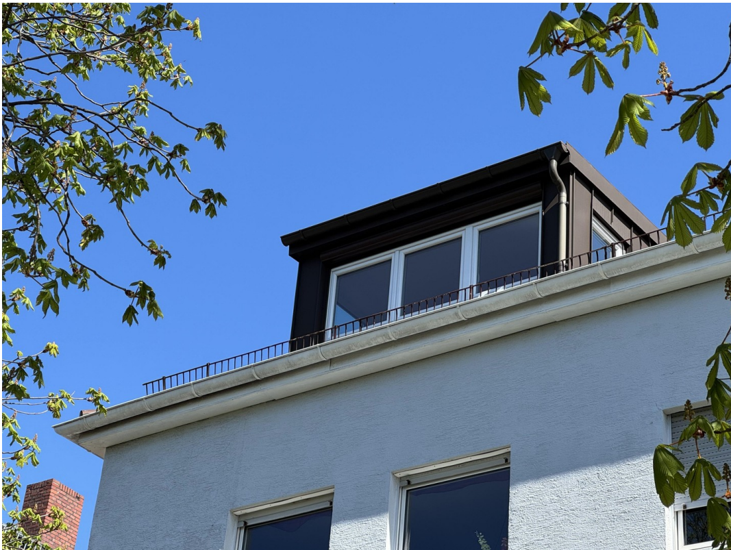
Fünf Fenster-Gaube Westen
