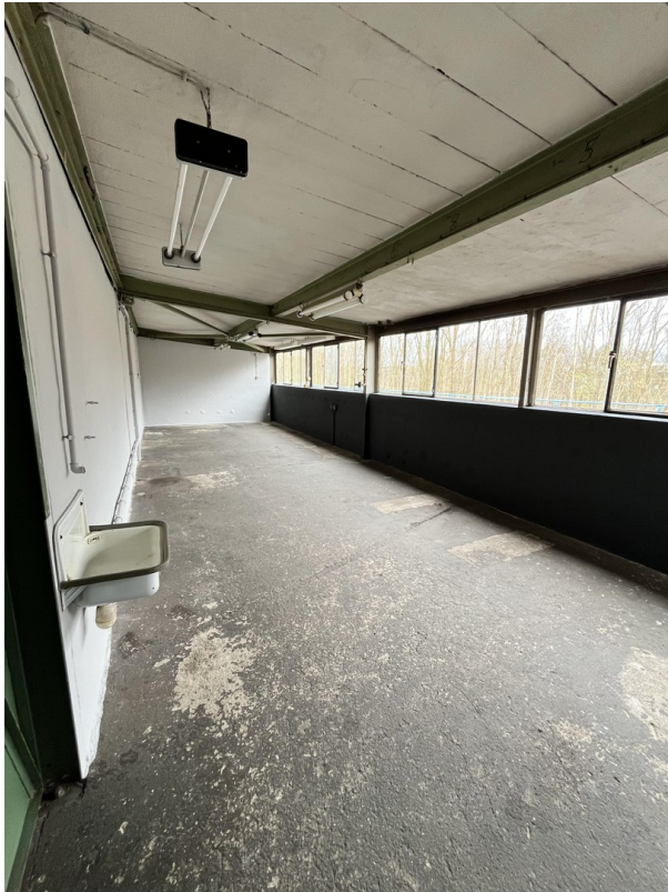
Halle 1 Nebenraum 1 - 860m 2
