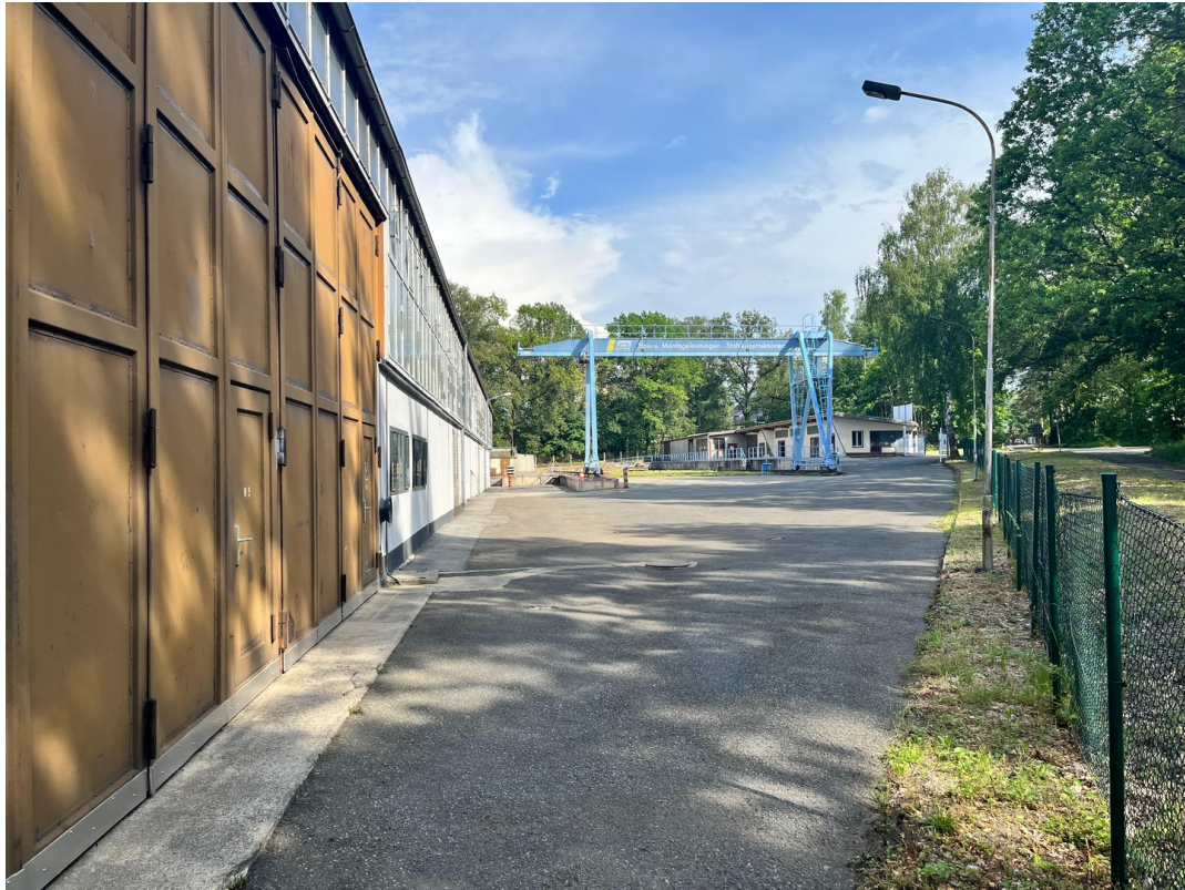
Halle 2 Zufahrt - 264,05m 2
