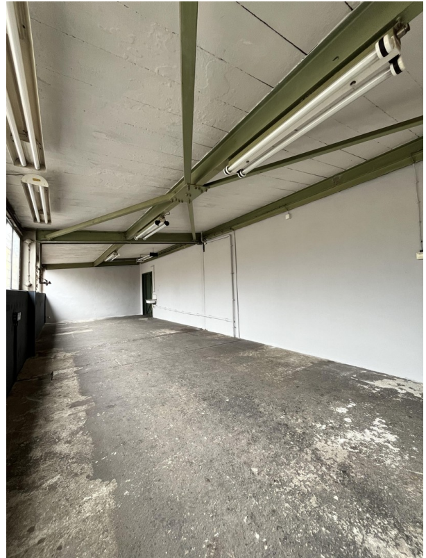
Halle 1 Nebenraum 1 - 860m 2
