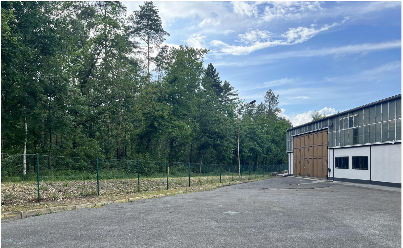
Halle 2 Zufahrt - 264,05m 2
