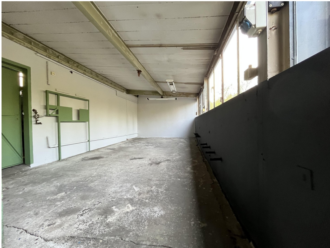
Halle 1 Nebenraum 2 - 860m 2
