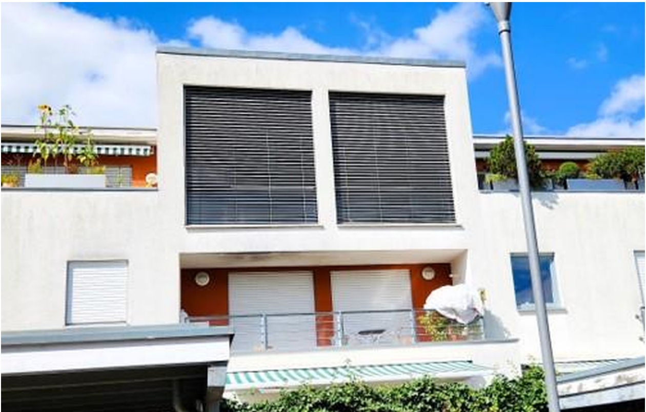
Fenster Wohnzimmer u Loggia
