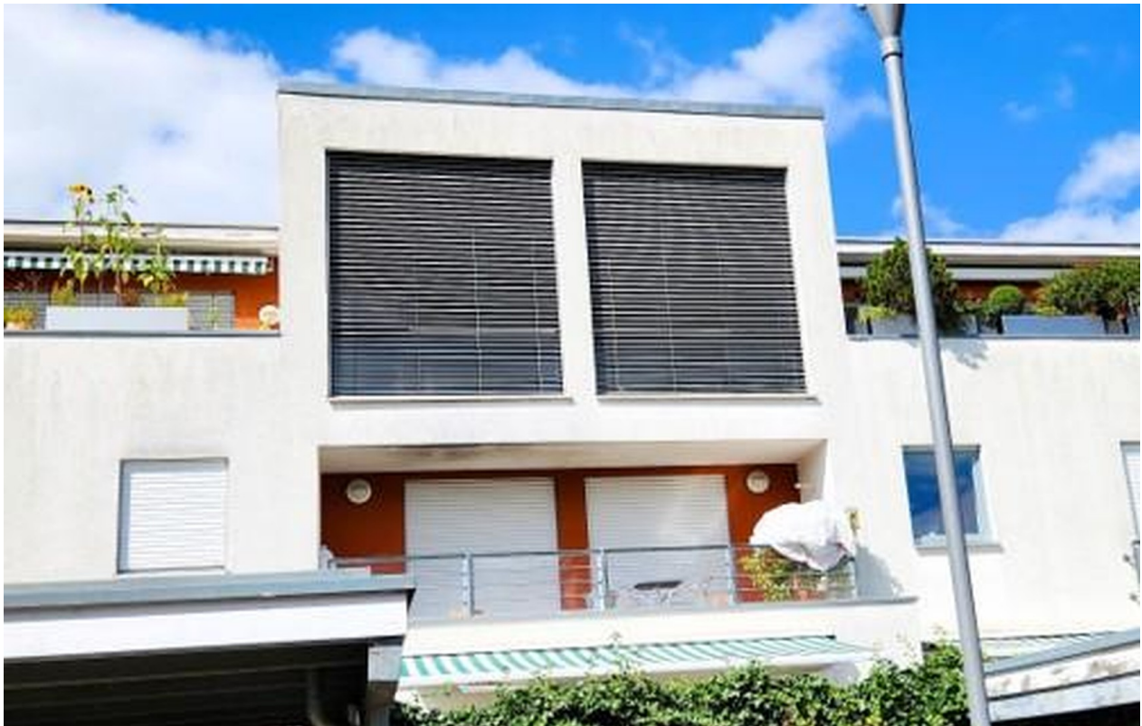
Fenster Wohnzimmer u Loggia
