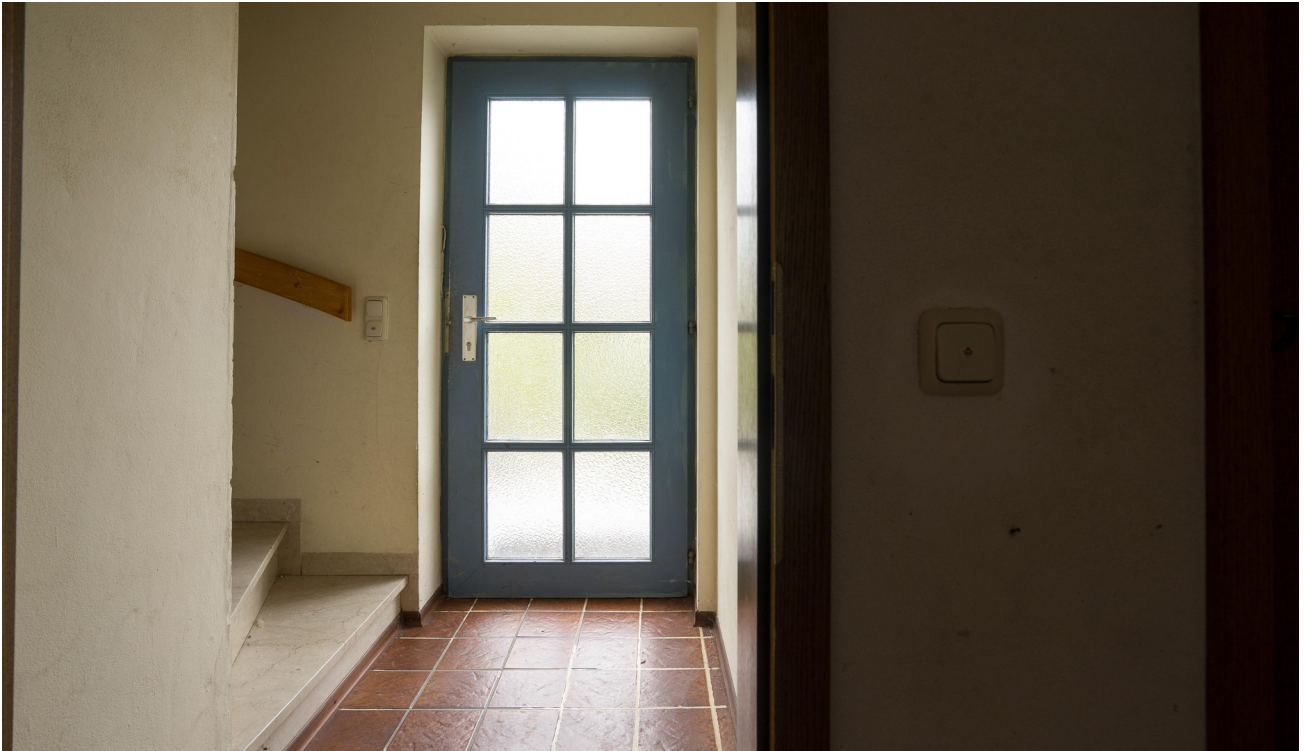
Haustür mit Windfang
