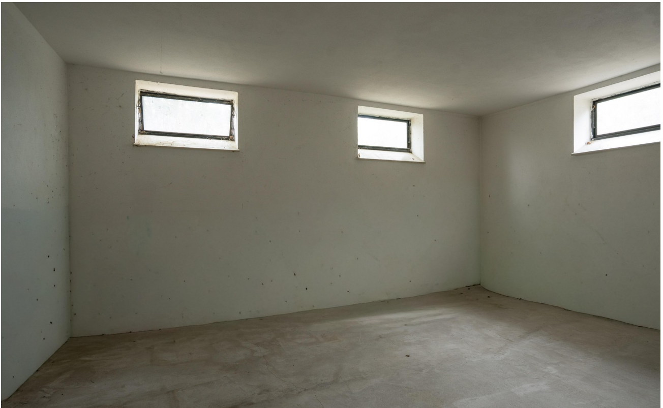
Kellerraum unter Wohnzimmer
