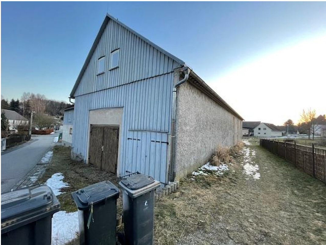
Scheunenanbau mit Weg
