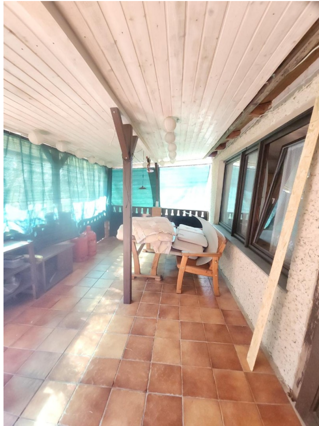
Terrasse mit Sichtschutz
