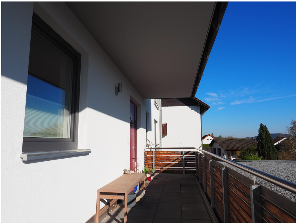
Überdachter privater Zugang
