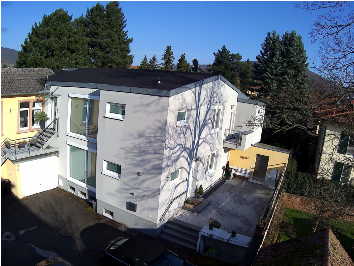
Blick Innenhof/ Eingänge
