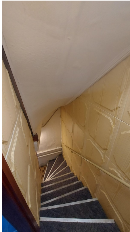
Treppe zwischen EG und Keller
