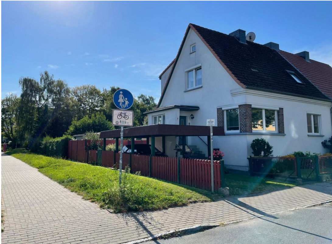
Ansicht West Straßenseite
