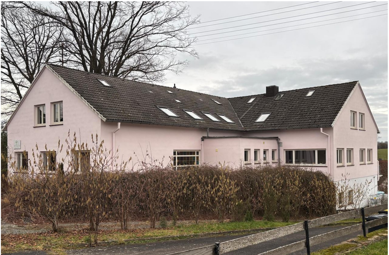
Ansicht von der Straße aus
