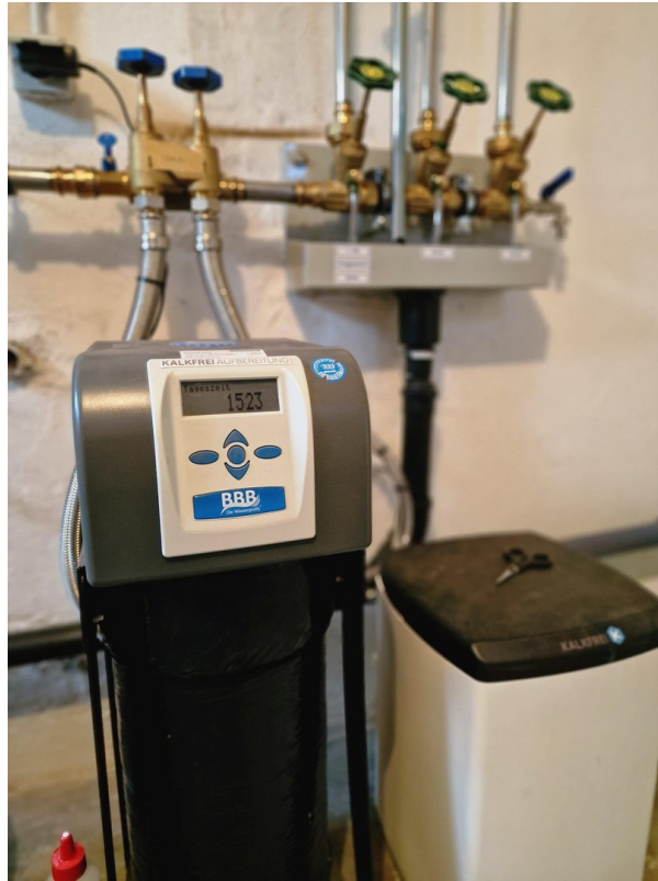
UG: Heizraum/Entkalkungsanlage
