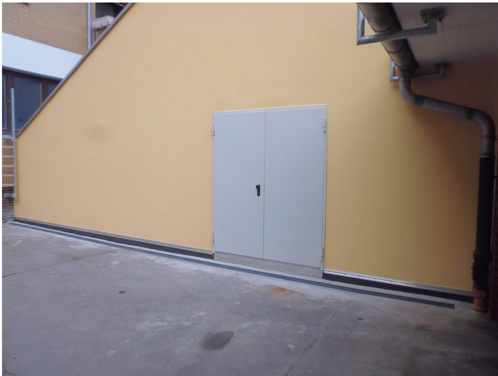
Zugang Sporthalle vom Hof
