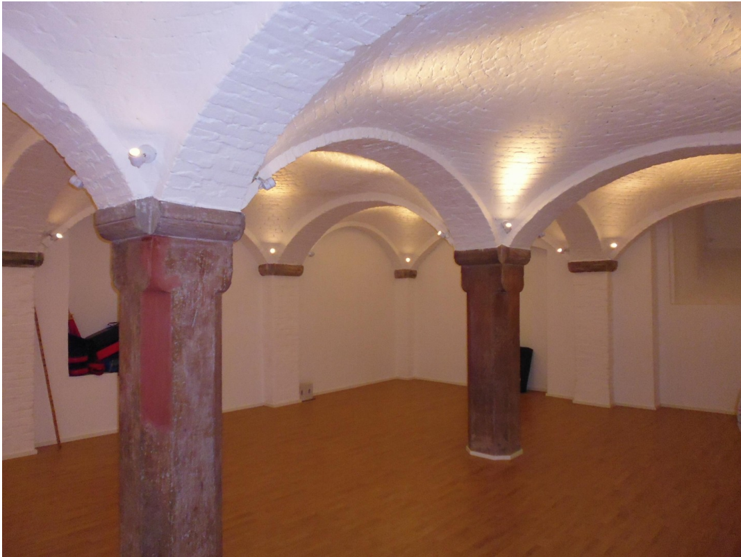
Lager und Aufenthaltsraum 2
