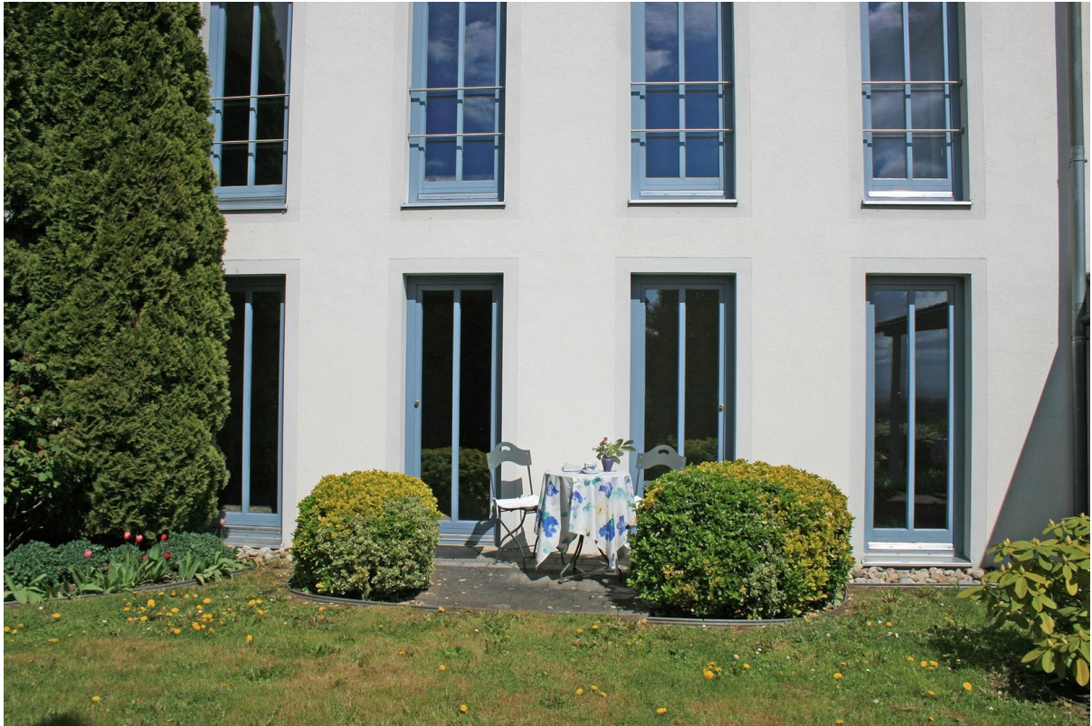
Detail Südseite mit Austritt
