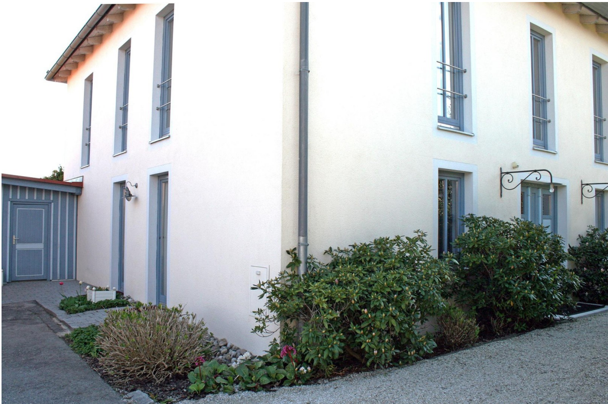
Haushälfte Ost- und Nordseite
