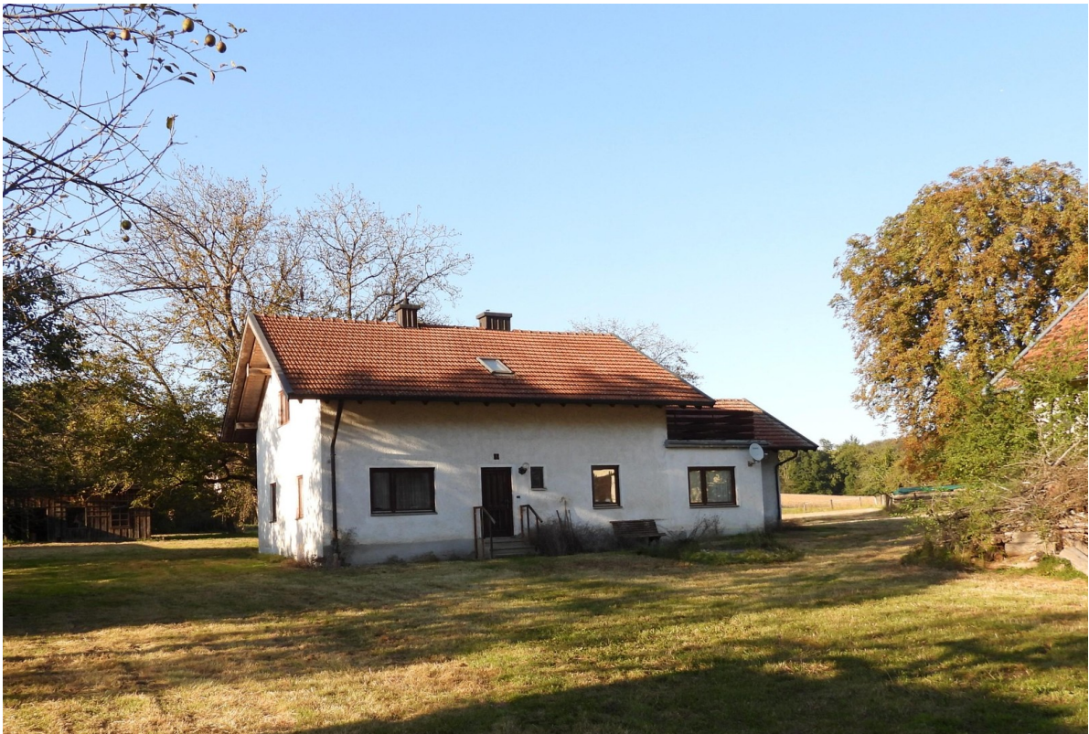
Wohnhaus Südseite mit Anbau
