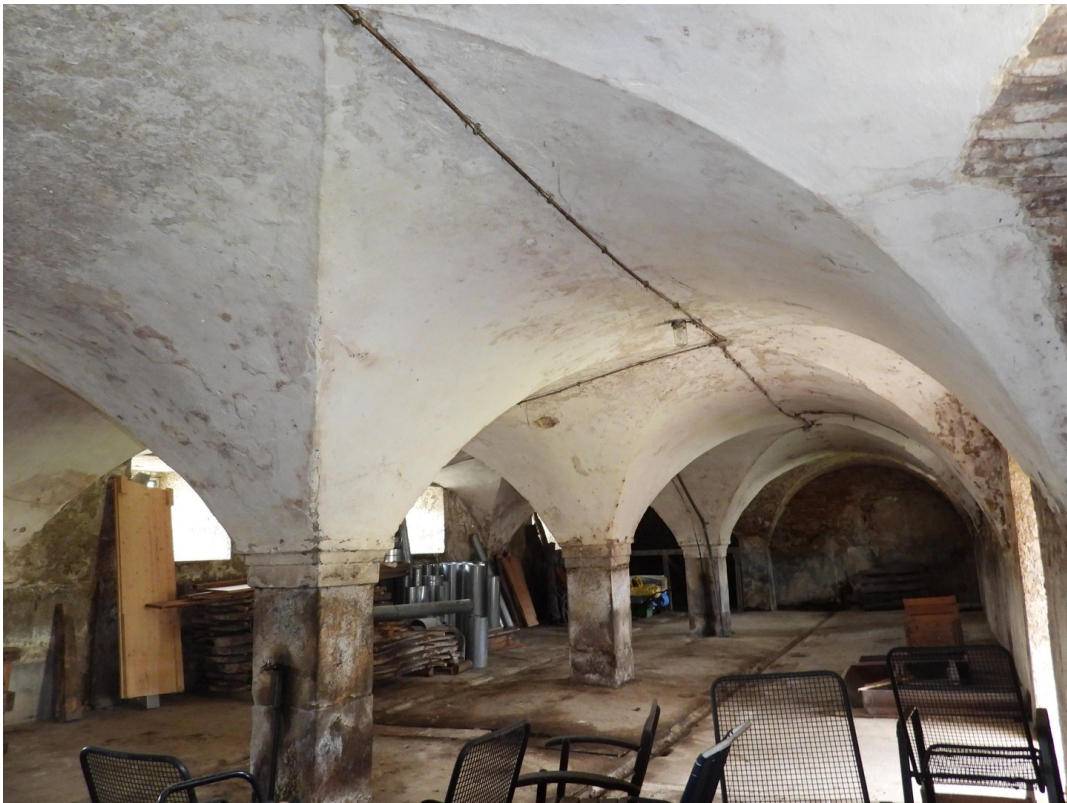
Gewölbe EG Zehentstadel
