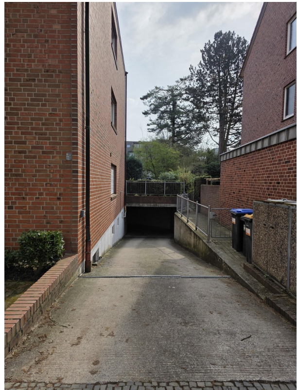
Einfahrt zur Tiefgarage
