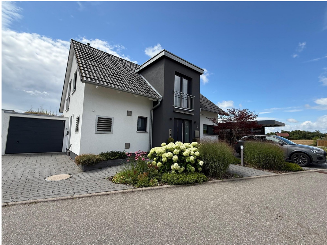
Zufahrt zur Garage
