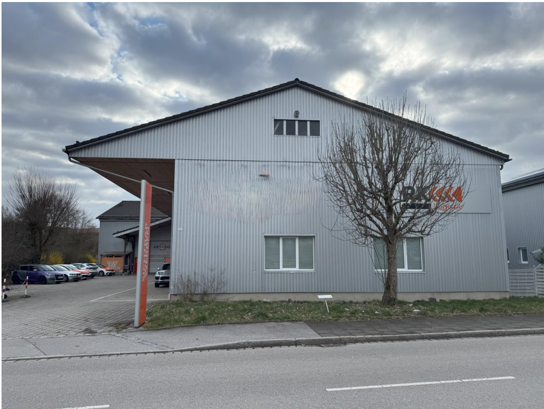
Ansicht von der Strasse
