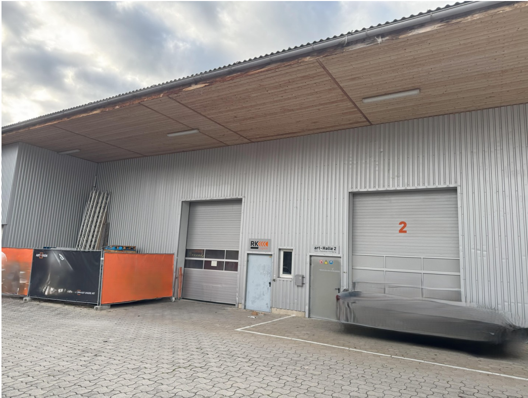
Vorbereich zum Hallentor
