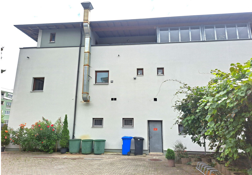
Parkplatz Innenhof Nordseite
