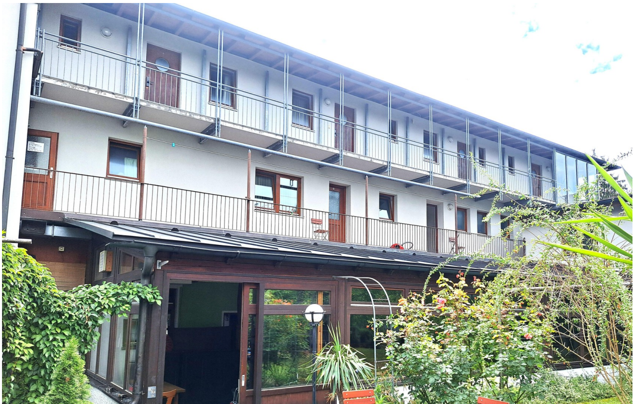
Sicht vom Garten (Nordseite)
