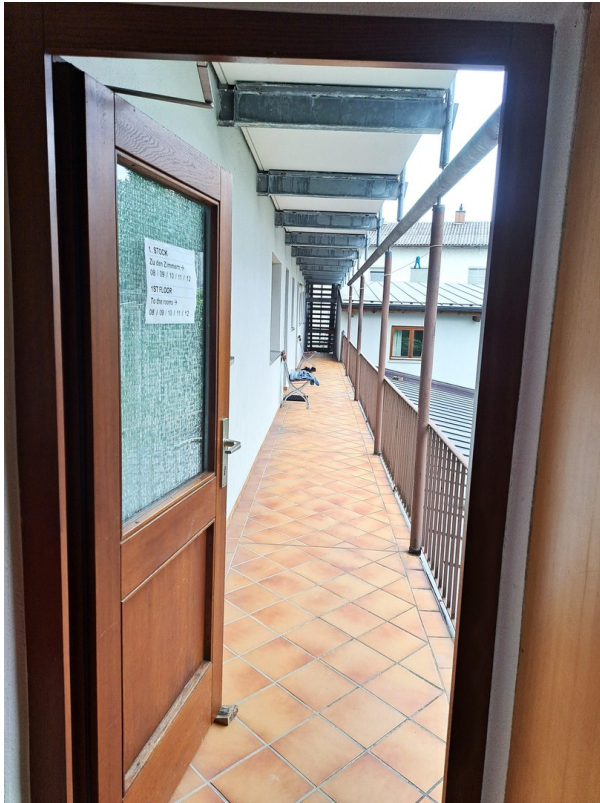
Zugang zu den Zimmern im 1. OG
