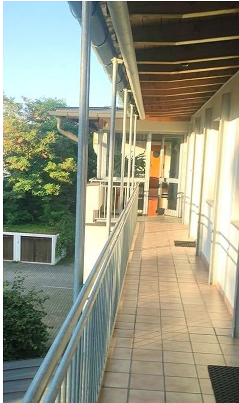
Zugang zu den Zimmern im 2. OG
