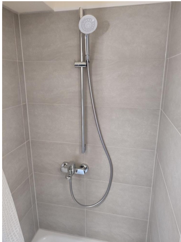
Dusche Wohnung / Büro
