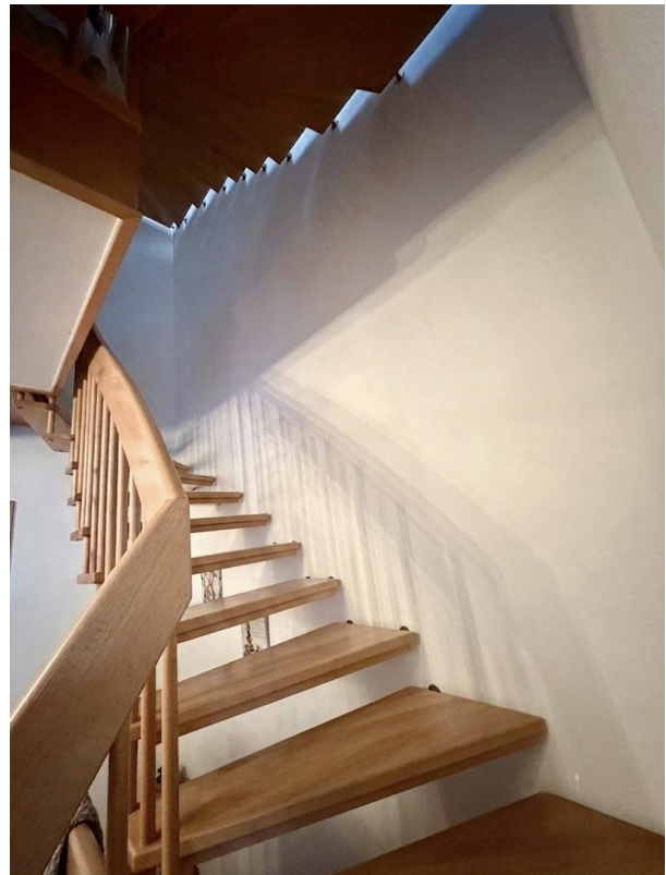
Treppe zum 1.OG
