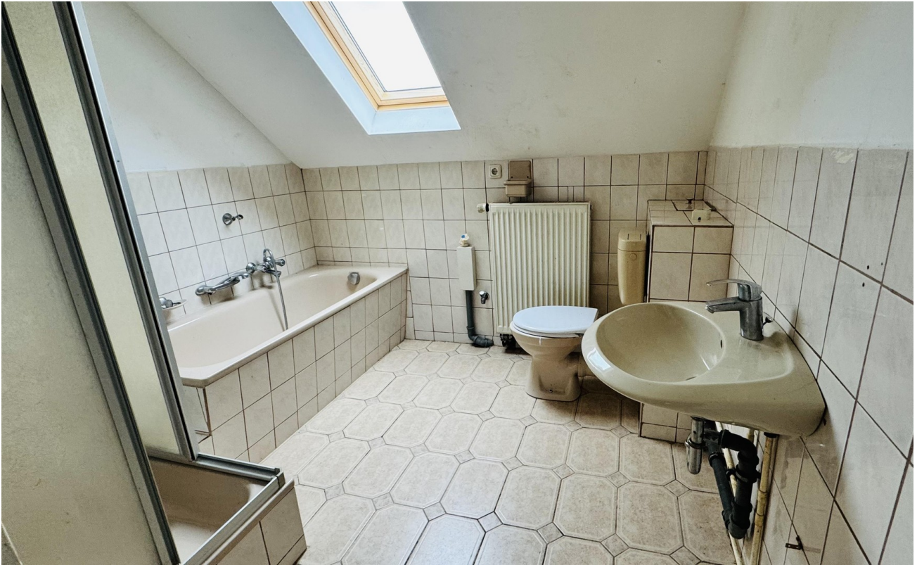
Bad - DG rechts
