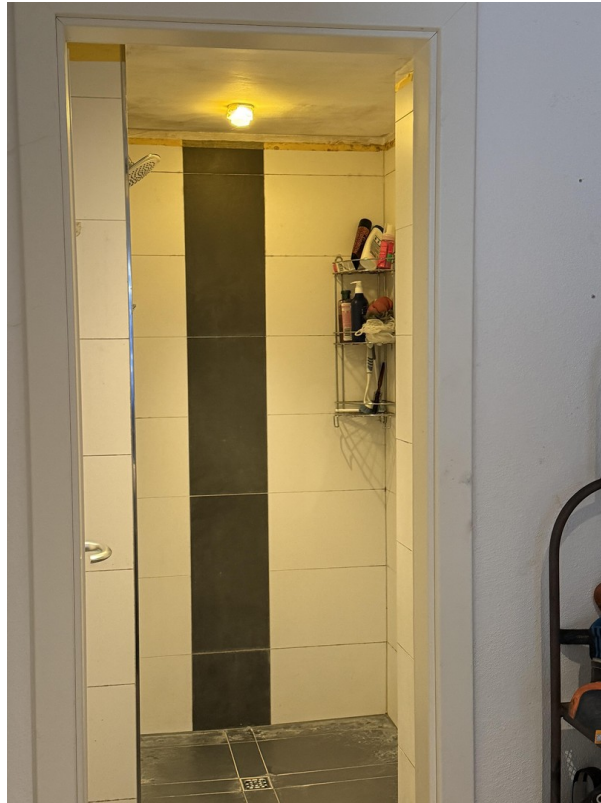
Duschbad EG aktuell
