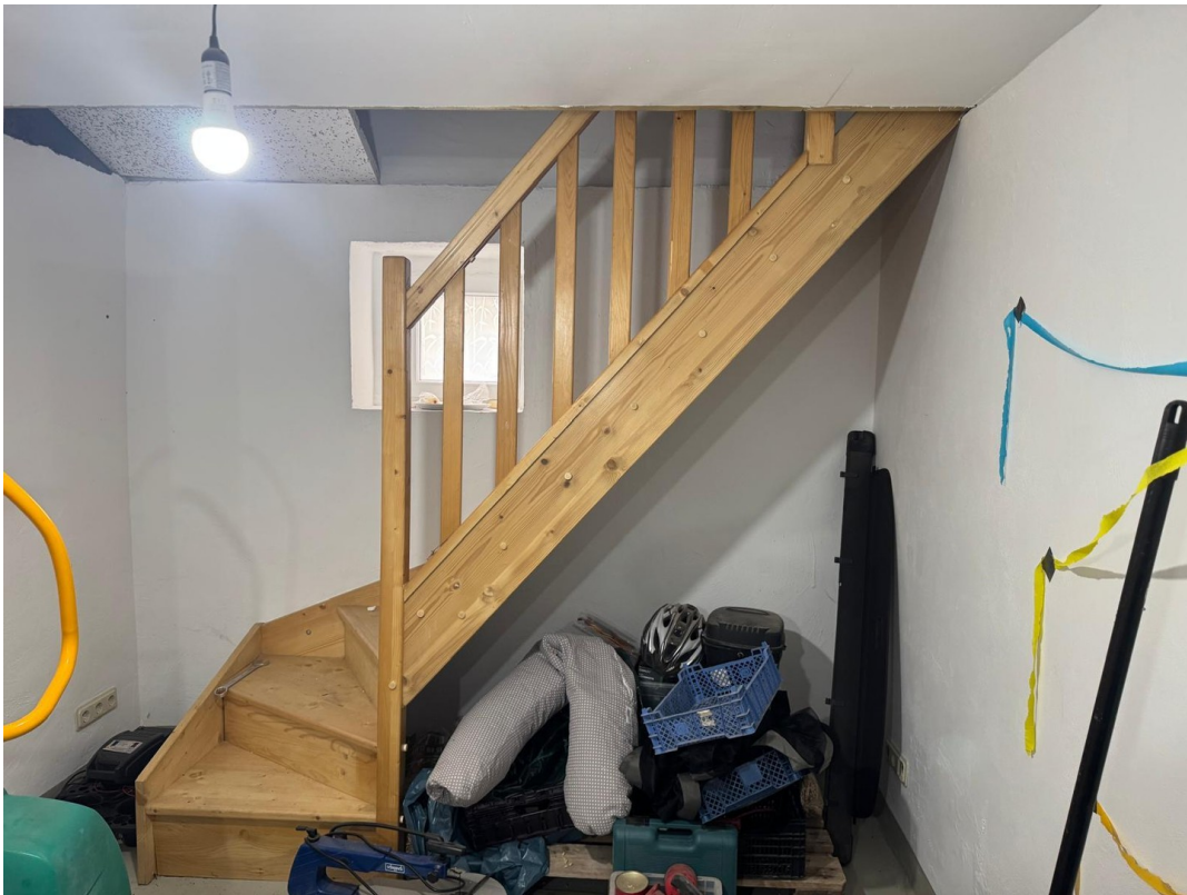
Aufgang auf den Scheunenboden
