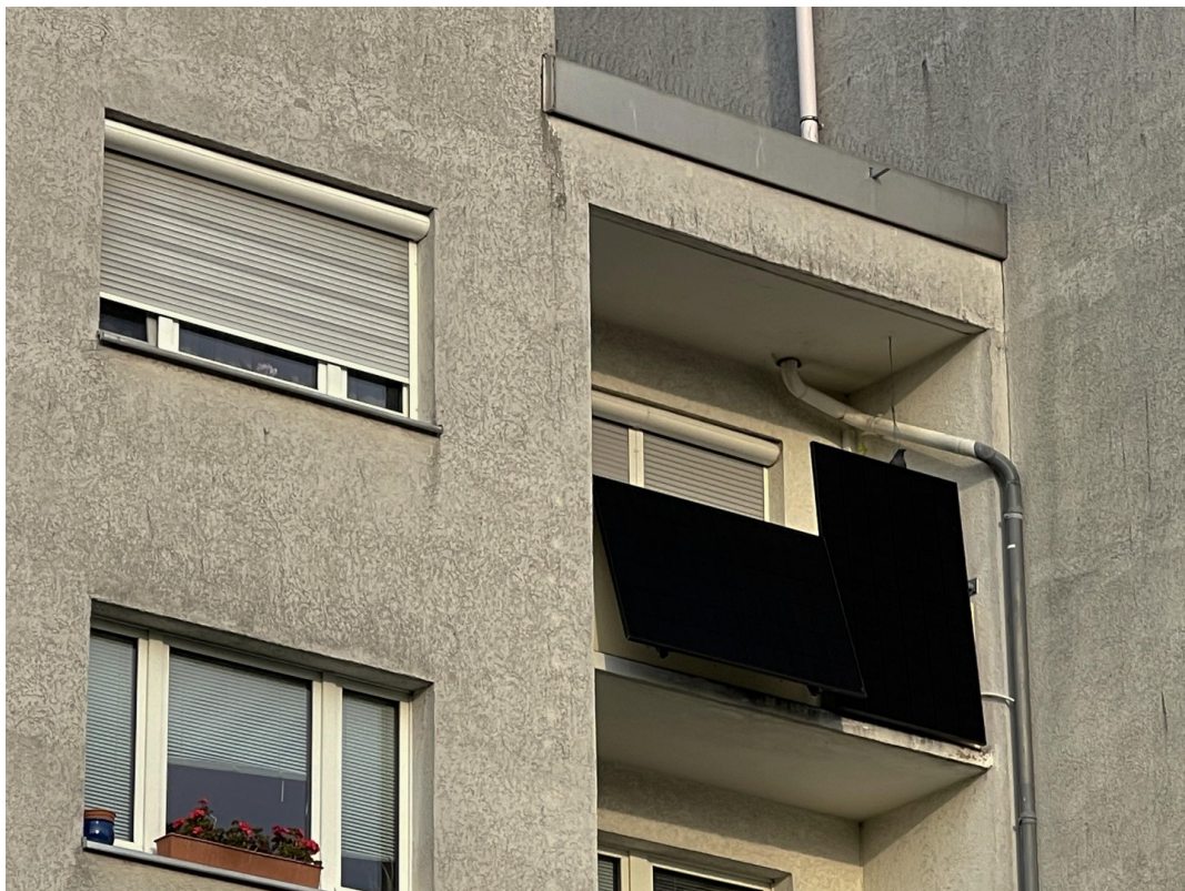
Balkonkraftwerk
