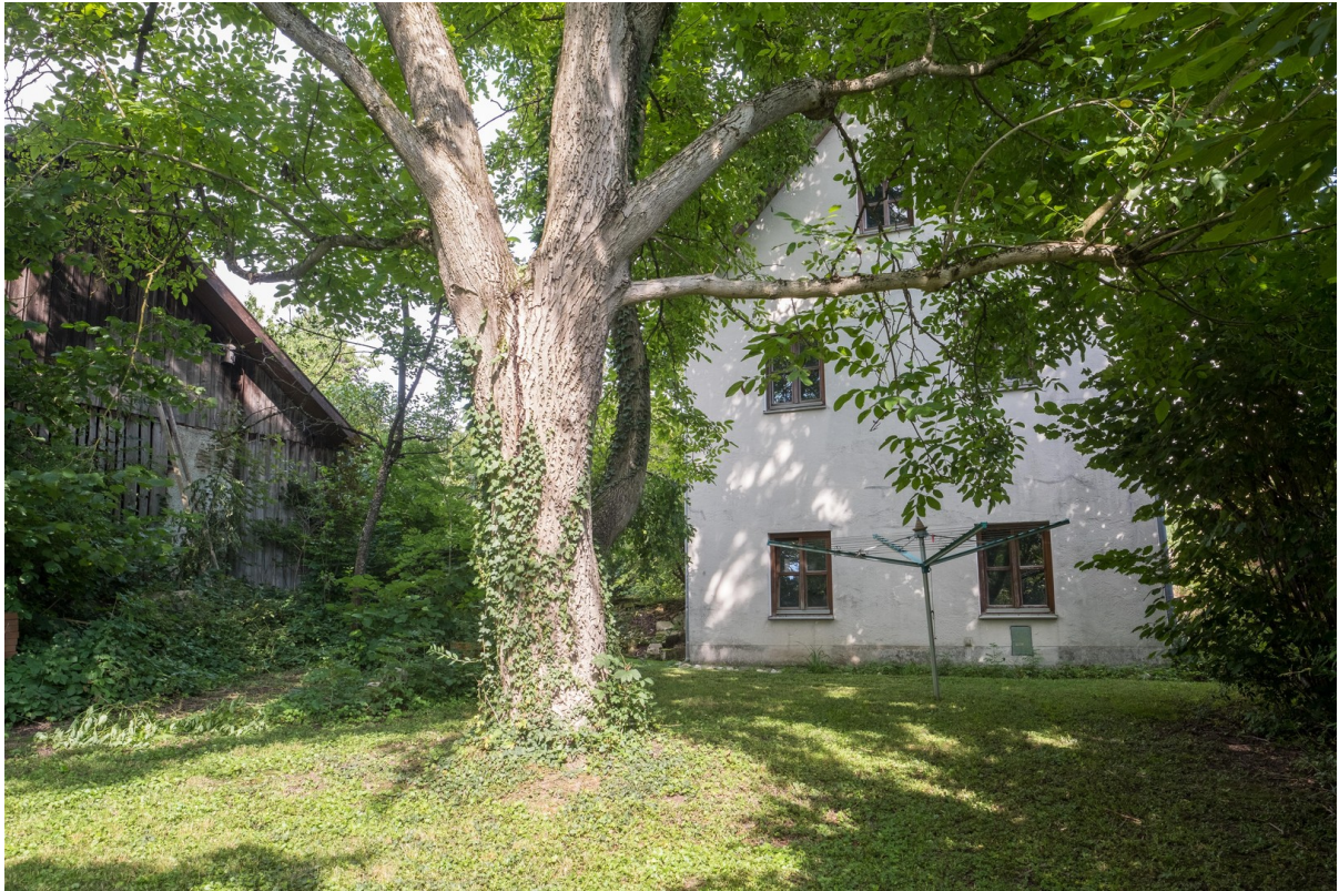
Blick auf Garage von Süden
