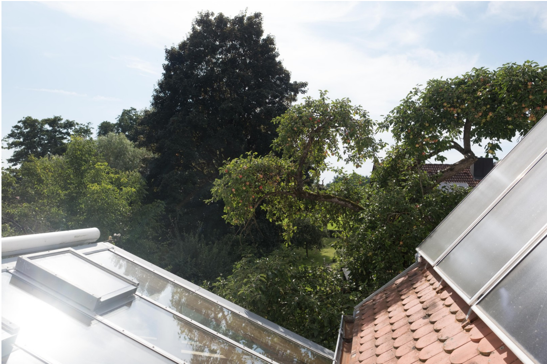
Blick Richtung Westen 2.OG
