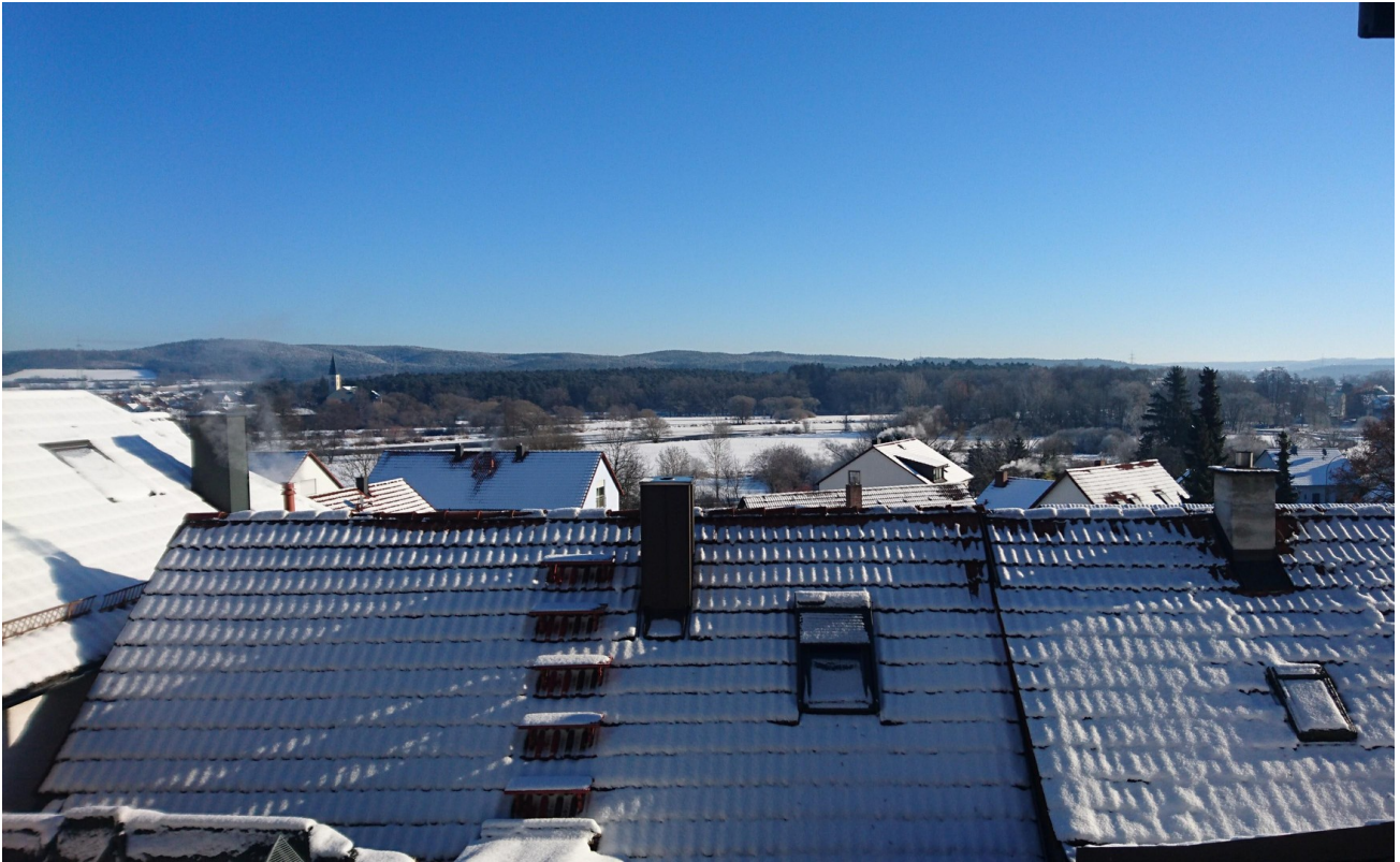
Blick über das Hausdach
