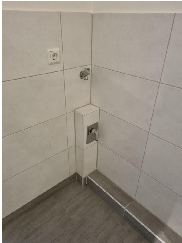
Waschmaschinenanschluss Bad
