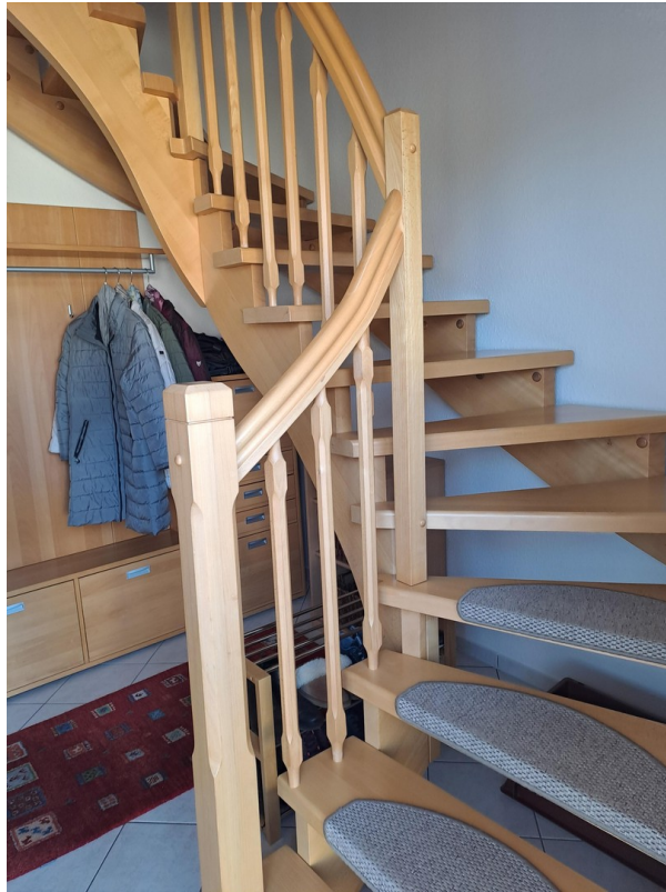
Treppe EG zum 1. OG
