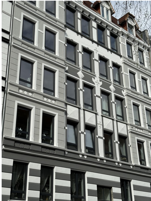
neu saniert mit Mineralfarben
