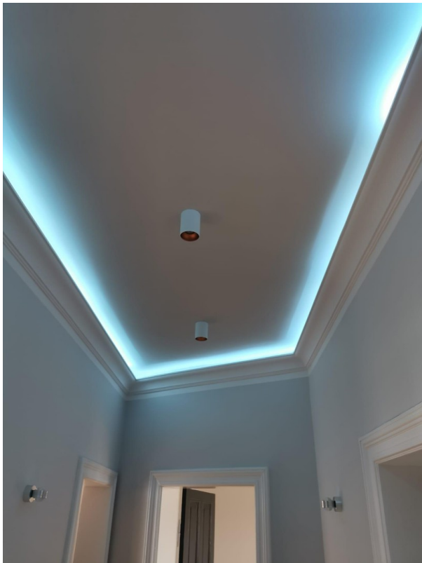
Stuckdecke mit LED im Flur/Bad
