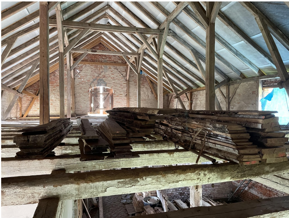
Zweite Ebene mit Dachbahnen
