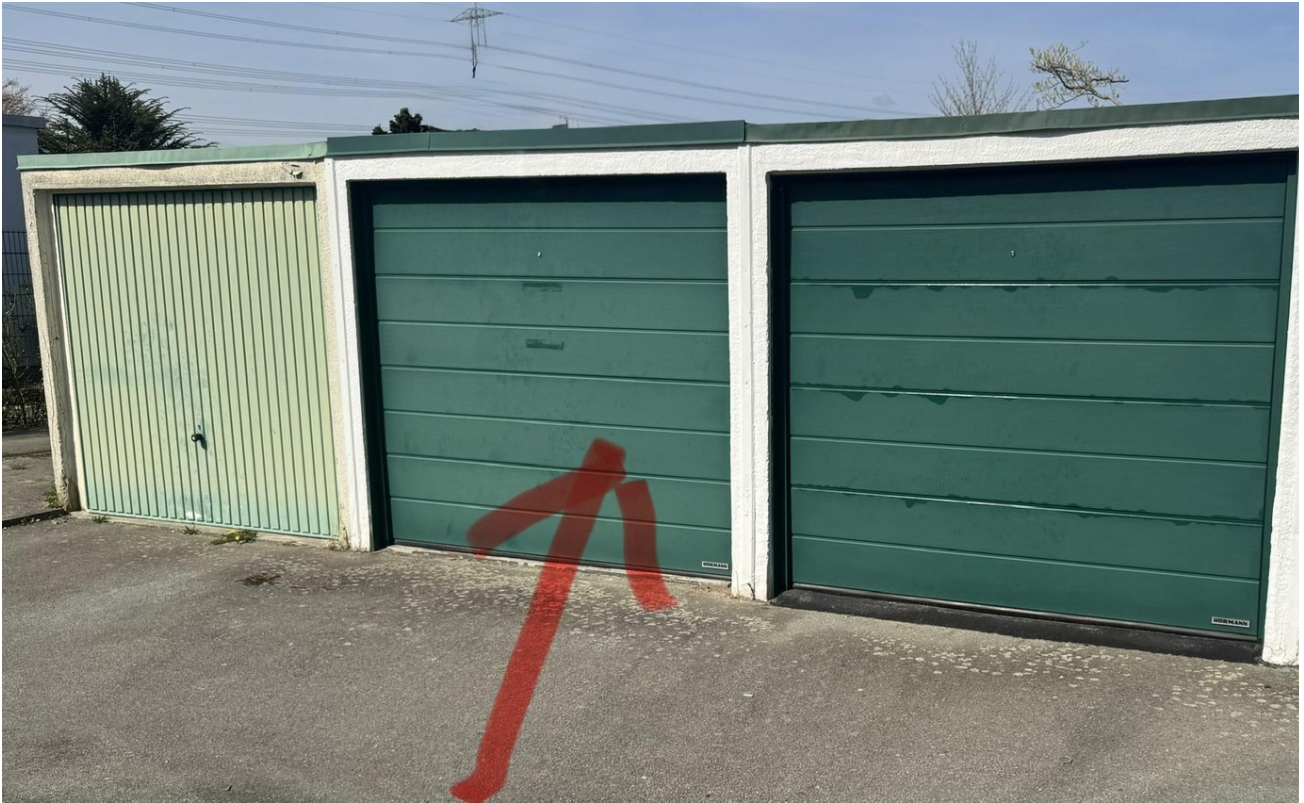
Einzelgarage Tor elektrisch
