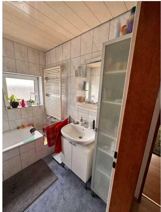
Badezimmer (wird kernsaniert)
